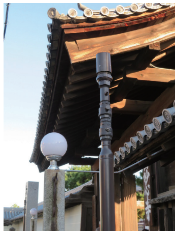
妙心寺北門脇に設けられた 街路壁面散水設備(WSS)
