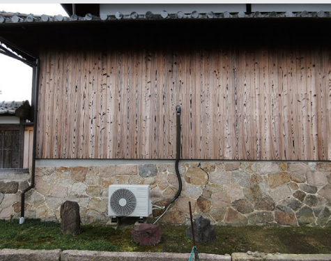
北側外壁 嵩上げ部分の地盤沈下 傾いた石積みの頂部を補修
