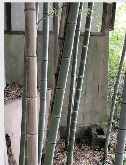
北西側擁壁 頂部垂直面に亀甲紋様の目地
