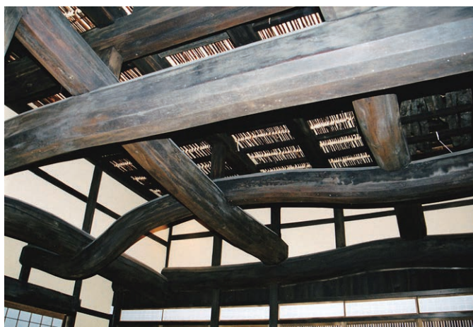
写真5 行永家住宅の土間梁組
