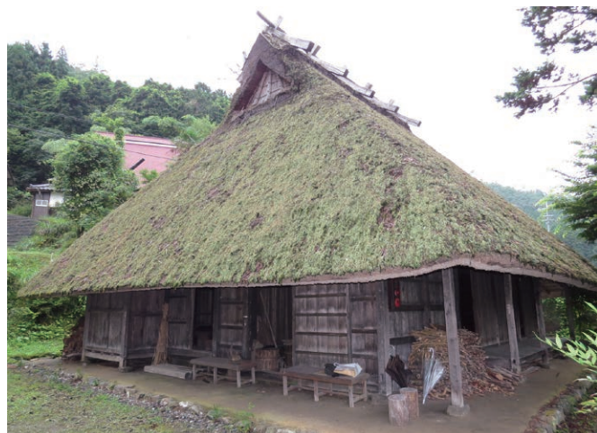
写真1 石田家住宅の外観
