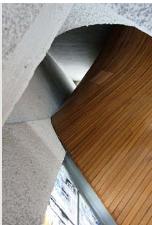
香部屋、尖塔の見上げ 白ラワンの天井は上昇し 菱形の開口部から光が降り注ぐ
