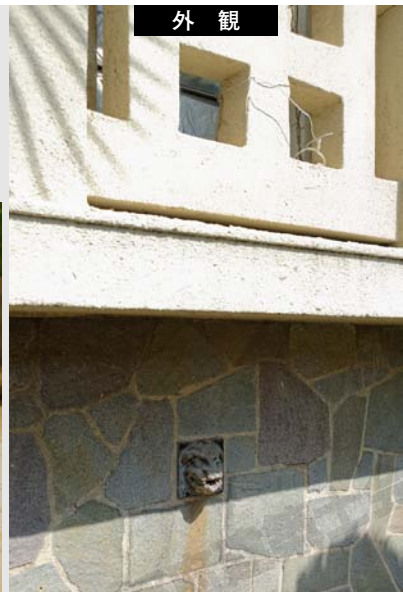
塔の足元、獣頭の吐水口
