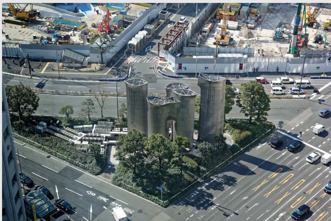
北東からの俯瞰 奥は、阪神百貨店の工事現場
