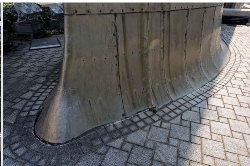
三次元曲線に加工された足元 地面のタイルと連続する
