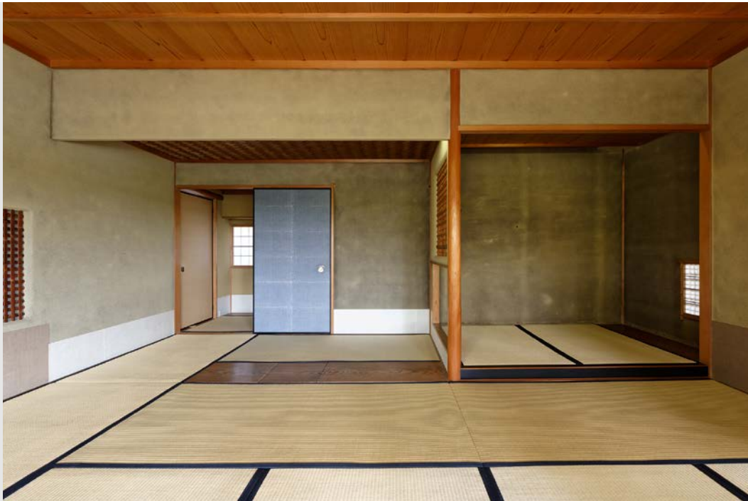
八畳半台目中板付の広間席の床の間 床柱、紋丸太、床框、杉面皮角の呂色漆塗仕上
