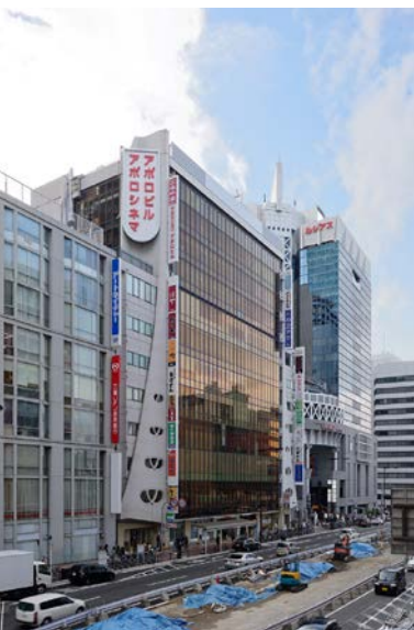
東側よりの外観 L型の袖壁の意匠とカーテンウォールに注目
