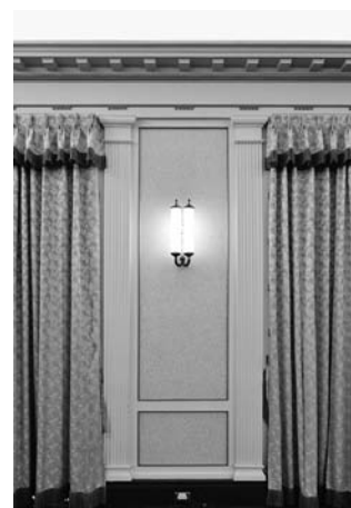
大会場・西面：ブラケットの両側に付柱が配されている。
