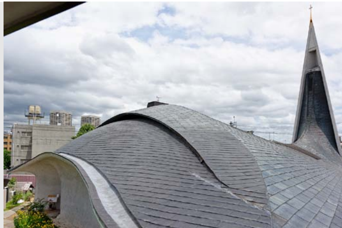
北西より銅板葺屋根の造形を臨む 尖塔の形態にも感動する
