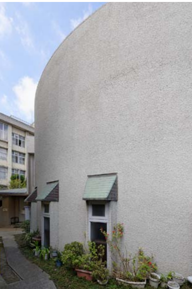
会堂南側壁面
