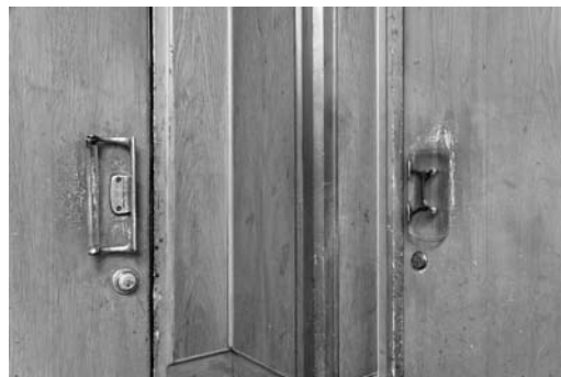
会議室の扉引手
