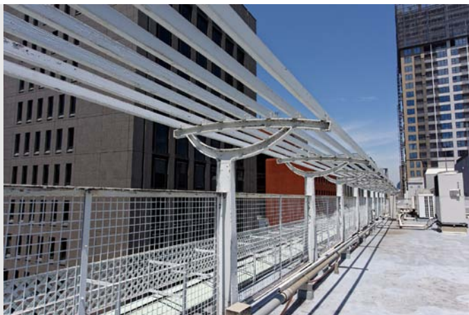
屋上の日除けの鉄骨フレーム
