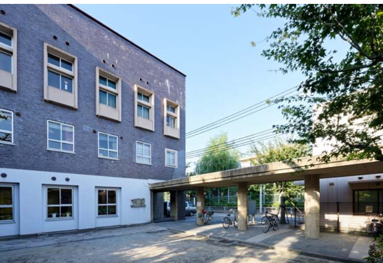
南側広場より東側廻廊アプローチを望む
