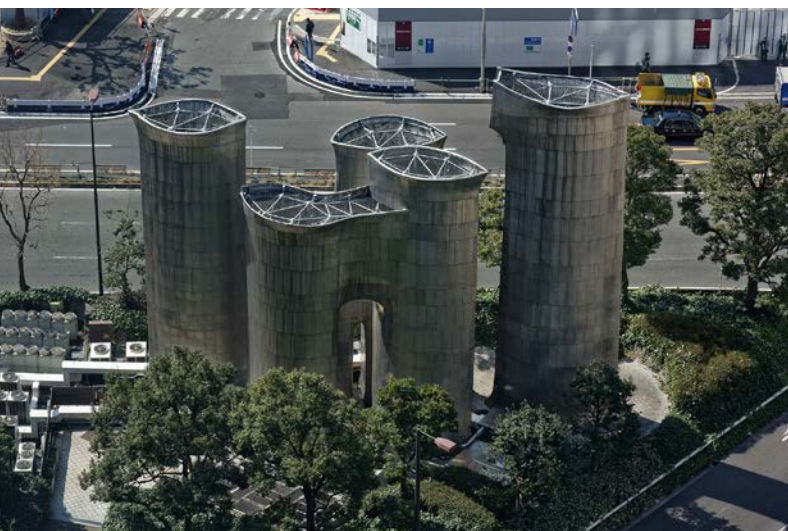
吸気塔の構造体と詳細
