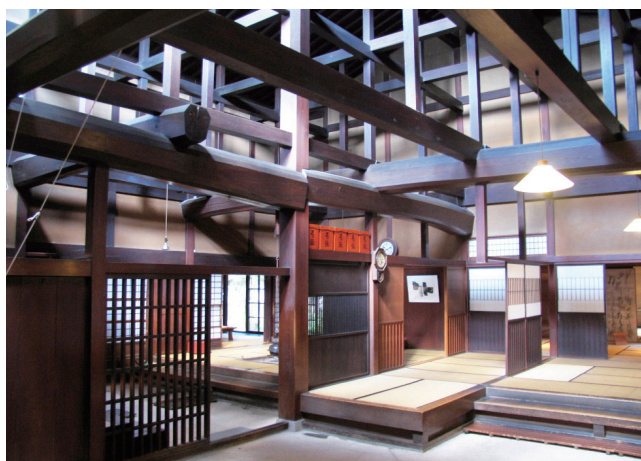
写真2 土間と梁組／吉島家住宅 (岐阜県高山市／1907年)
