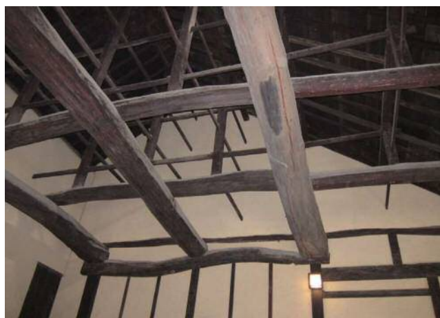
写真5 今西家住宅の土間梁組 (奈良県今井町／1650年)
