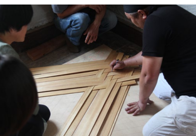
写真12 交流会で網代天井の編み方を指導
