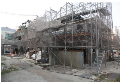
写真7 修理中の外観
