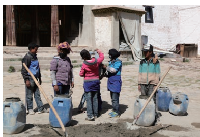
写真6 セラ寺子院建築現場
