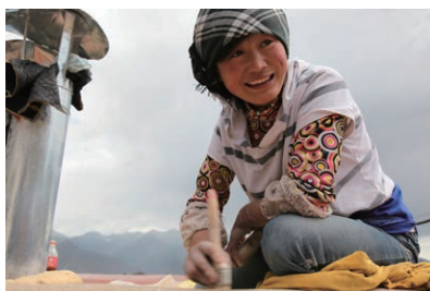
写真7 陸屋根 パラペット仕上
