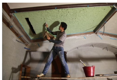
写真3 2階主応接室の天井仕上げする日本の職人
