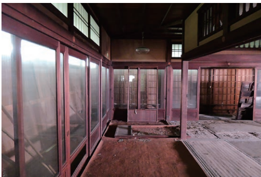
写真3 三夜荘 座敷、畳廊下
