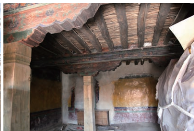
写真2 陸屋根 天井大引と肘木
