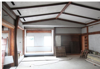
写真2 2階上座敷の修理状況
