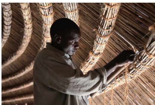
写真10 エレファントグラス母屋の取付
