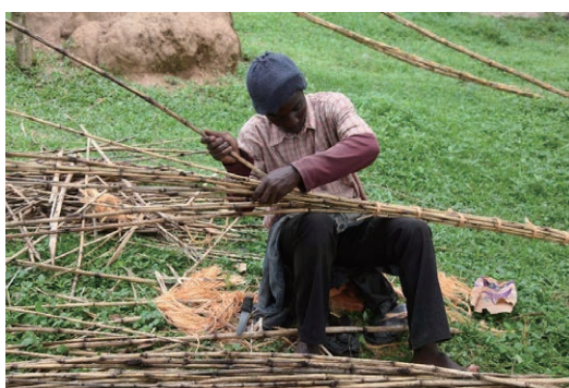
写真9 エレファントグラスの母屋製作
