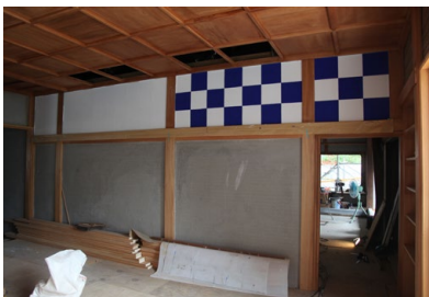
写真5 2階広間の市松模様壁の修理状況
