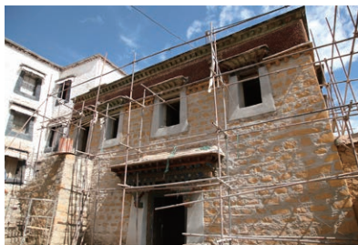
写真5 セラ寺コンクリート練
