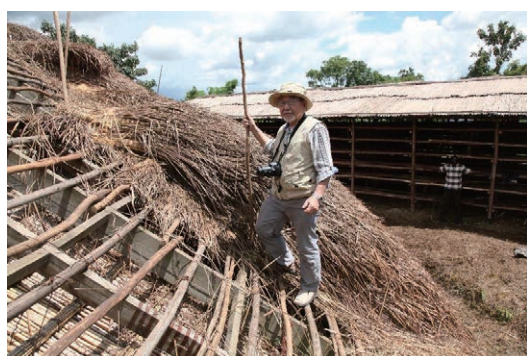
写真11-1 ワマラ王墓スピアグラスの葺重ね (中央は日塔和彦先生)
