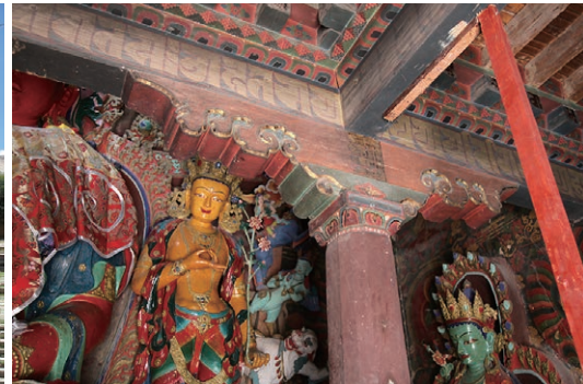
写真10 白居寺 多門塔初重西中央室の持送り
