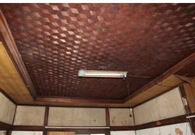
写真11 2階光瑞の私室の網代天井
