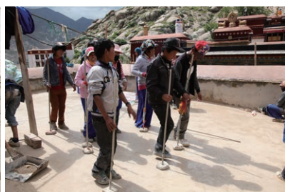
写真3 陸屋根叩き仕上げ
