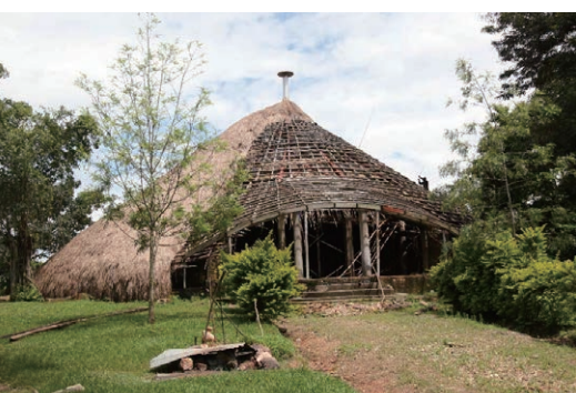
写真5 ワマラ王墓 屋根葺工事
