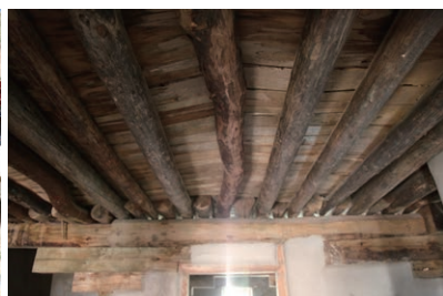
写真1 子院内部天井
