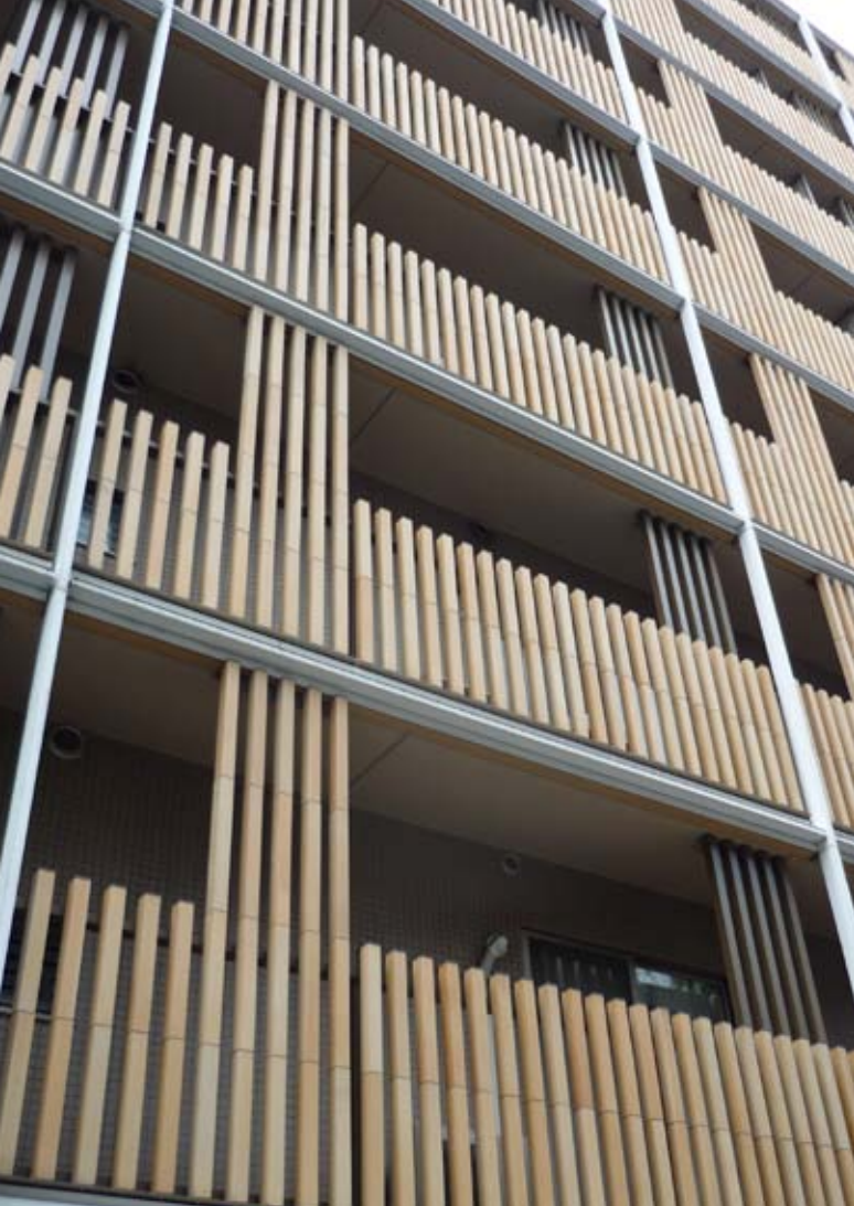
④グランブルー三條柳馬場(2002年・京都市中京区) 道路に面した外壁全面をセラミック製の格子で覆ったマンション。格子はバルコニーの手すりの機能も担っている。
