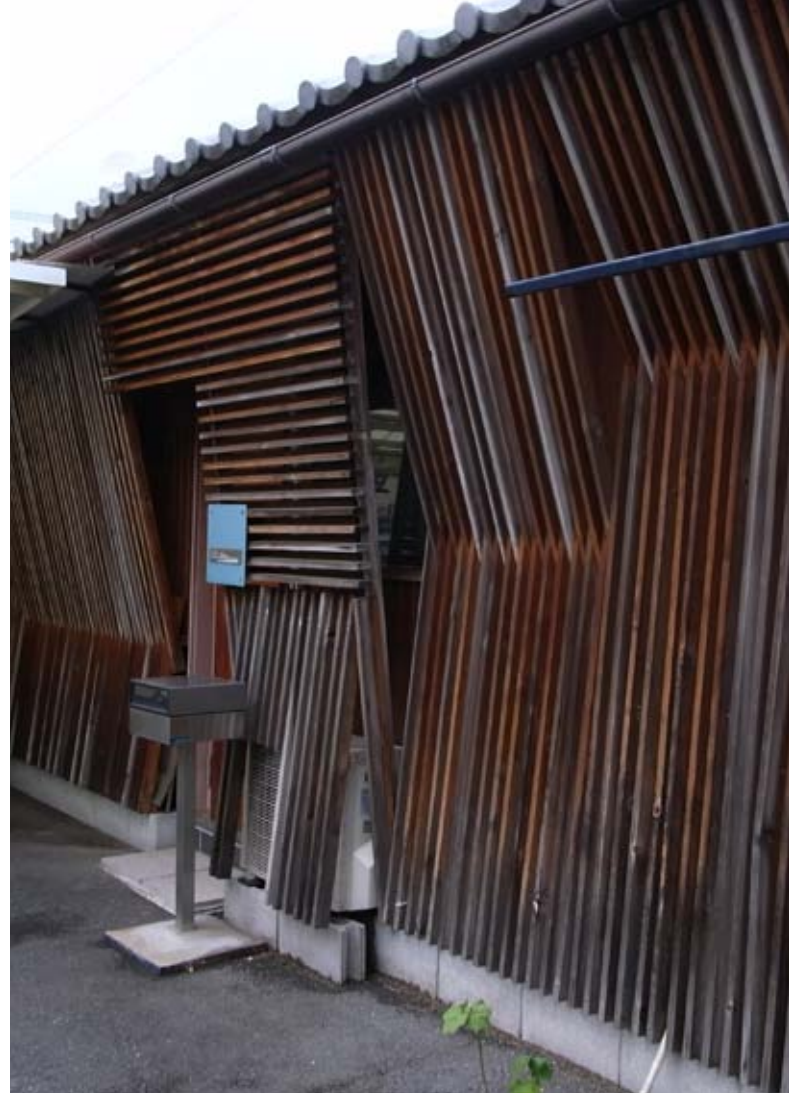
③川端三條の格子外壁(不詳・京都市左京区) 元々単調な外壁だったところに、後付けで全面に格子を施したもの。外壁と格子の間に設備機器などを隠すと同時に、照明を仕込んで夜景にも配慮していた。近年、建物の老朽化のために取り壊された。
