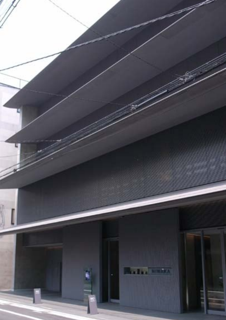
④ 俄ビル (2009年・京都市中京区)
