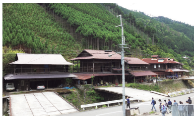
中川地区の木造倉庫群
