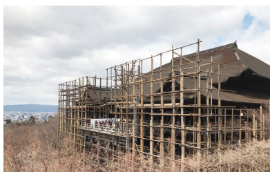
保存修理工事中の清水寺
