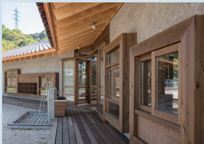
園庭に沿う軒下廊下
