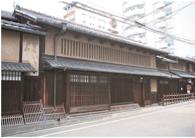
写真5 杉本家住宅の外観
