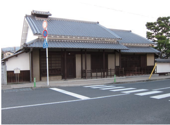
写真7 須田家住宅の外観
